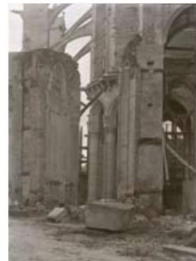
Le chœur de la cathédrale en travaux, vers 1890 (Arch. dép. de l'Orne)
